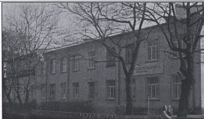
Фото 5. Западный фасад памятника.
