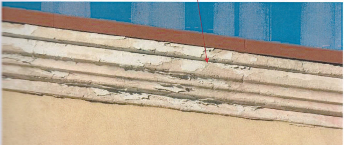
Северный фасад восточного и западного объёма: Стена и цоколь оштукатурены, окрвшены, цоколь частично закрыт отсыткой. Стена восточного объёма завершена профилированным венчающим карнизом под наклонным скатом крыши. Стена западного объёма завершена полуфронтоном треугольной формы с прерванной горизонталью основания. На карнизах фронтона наблюдается нарушение красочного слоя. Перед дверными проёмами в уровне первого этажа восточного и западного объёмов выполнено общее крыльцо с навесом. Дверной проём по центральной оси западного фасада выполнен в прямке.
