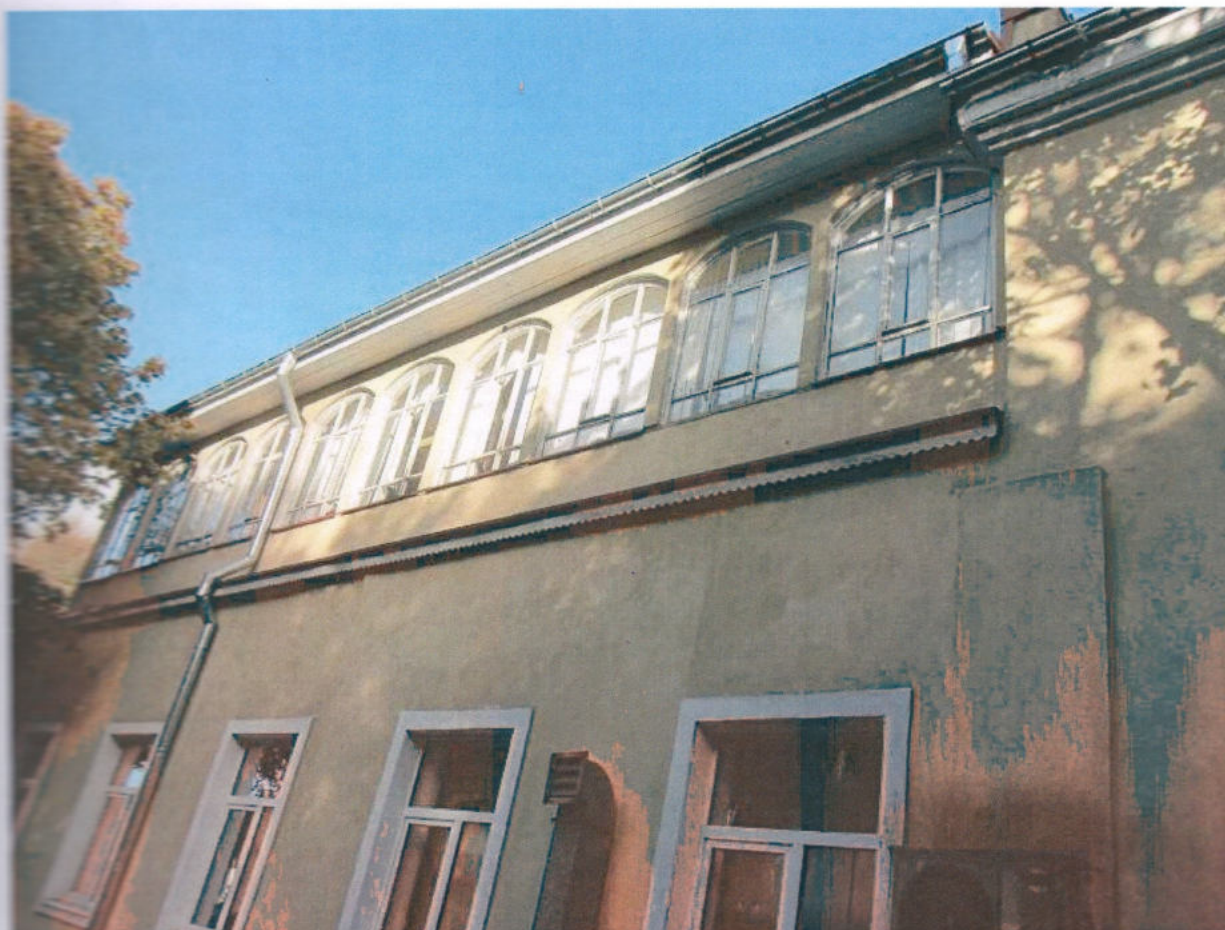
Западный фасад основного объёма: стена оштукатурена, окрашена. Межэтажный карниз с деревянным покрытием. Заполнения оконных проёмов первого этажа – стеклопакеты, второго этажа – деревянные рамы.
