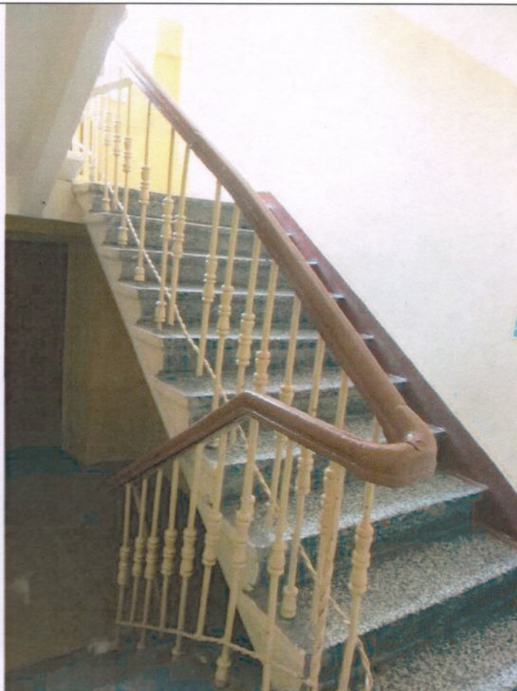
Западный объём: межэтажная лестница выполнена в южной части здания, двухмаршевая, бетонная, с покрытием ступеней и площадок из мозаичного бетона. Перила металлические, с фигурными балясинами, ручки деревянные. На ступенях наблюдаются выбоины.
