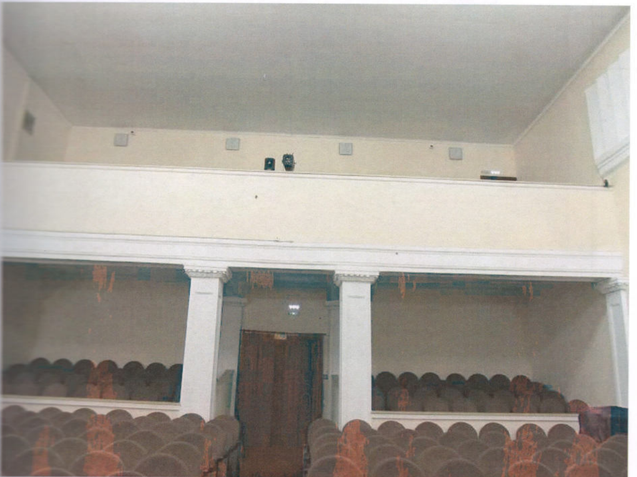
Западный объем: актовый зал выполнен в два яруса, в уровне второго яруса выполнены три балкона с глухими парапетами. Балкон над входом выполнен по колоннам и пилястрам прямоугольного сечения. Стены и потолок оштукатурены, окрашены, пол с паркетным покрытием.
