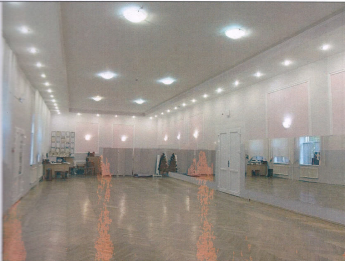
Восточный объём: стены зала оштукатурены, окрашены, пол паркетный, потолок подвесной.
