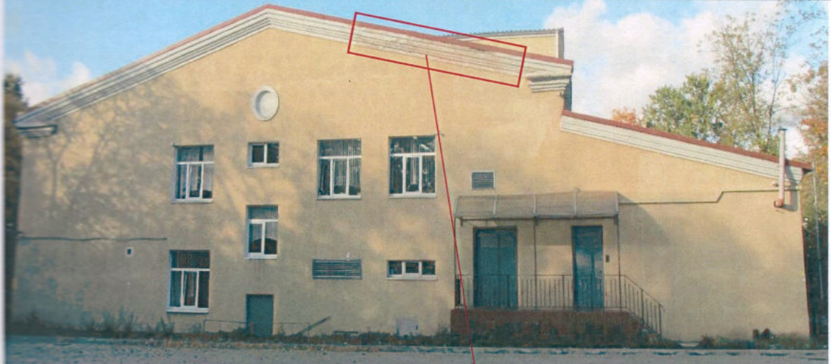
Восточный объём, восточный фасад: повреждены профили венчающего карниза.
